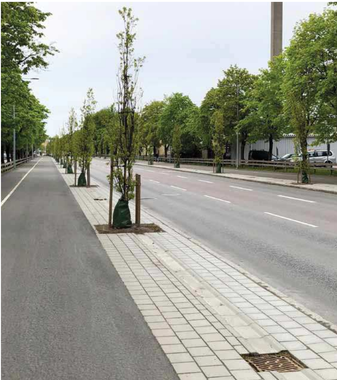
Nové stromořadí ve Växjö tvoří linie stromů na prokořenitelné vrstvě, do které je dešťová voda sváděna jak z pěších a cyklistických povrchů (nalevo), tak i z vozovky (napravo)
