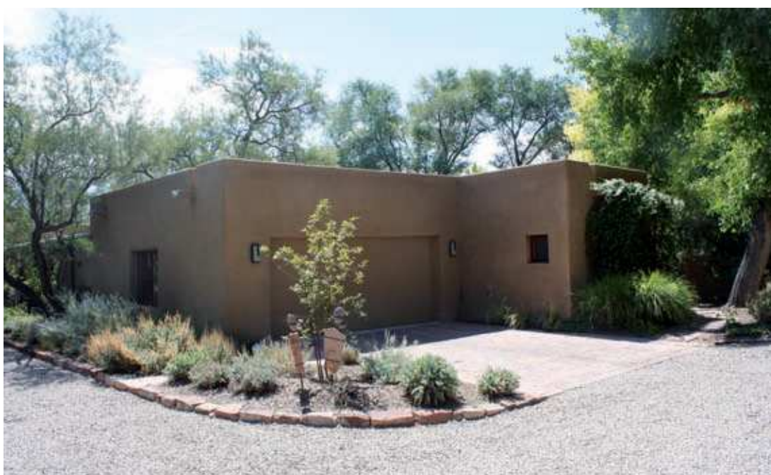
Garáž po rekonstrukci. Přístavba vpravo je nová koupelna
