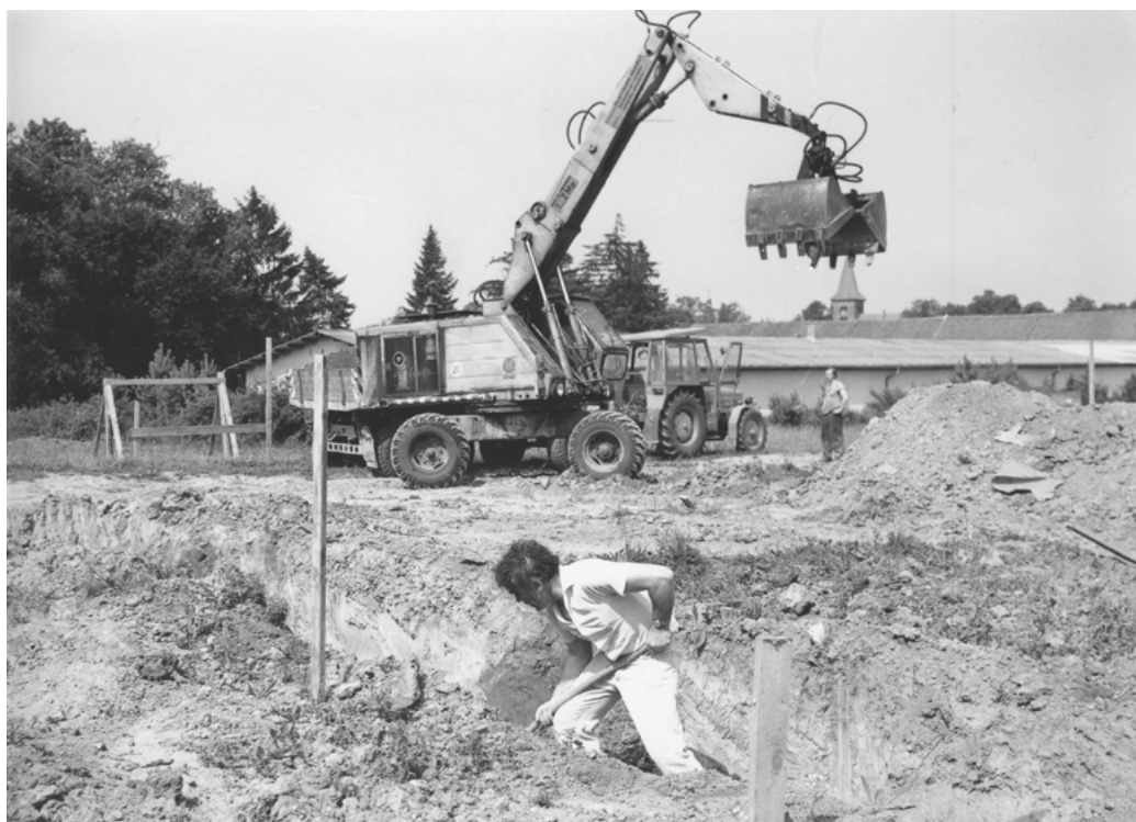
Prof. Mareček na stavbě budovy VÚKOZ, 1980
