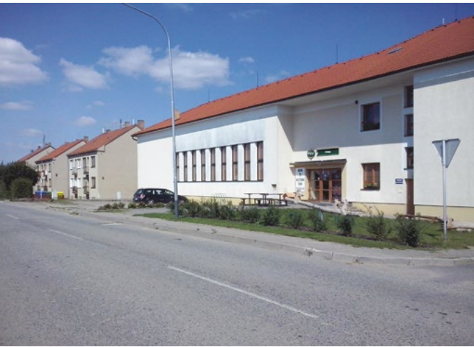
▲ Průčelí budovy kulturního domu v Petrovicih před úpravou (2020)
