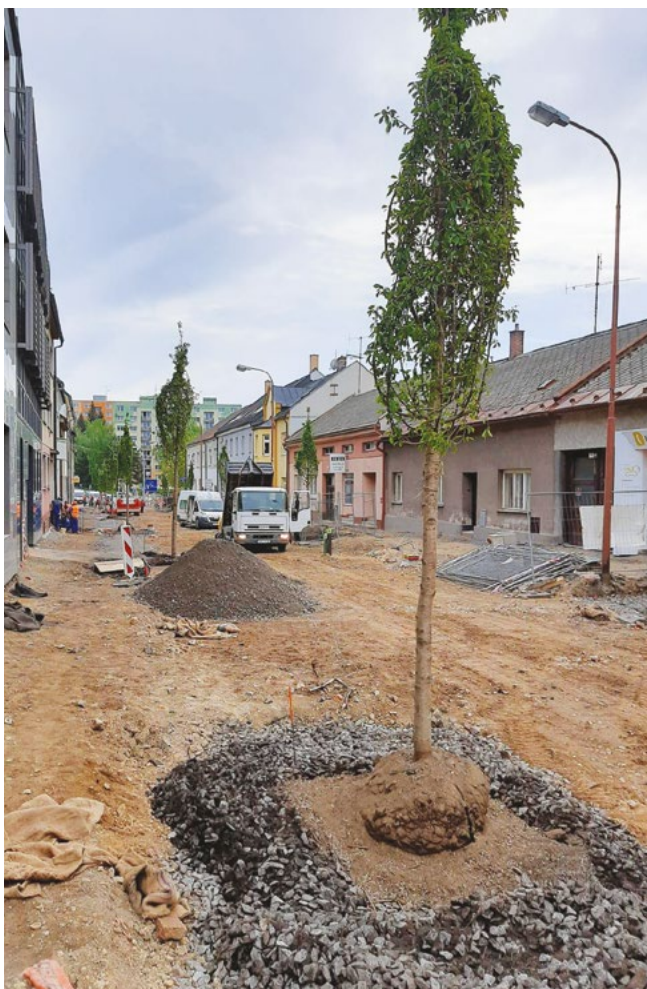
▲ Výsadba do strukturálního substrátu. Foto David Hora
