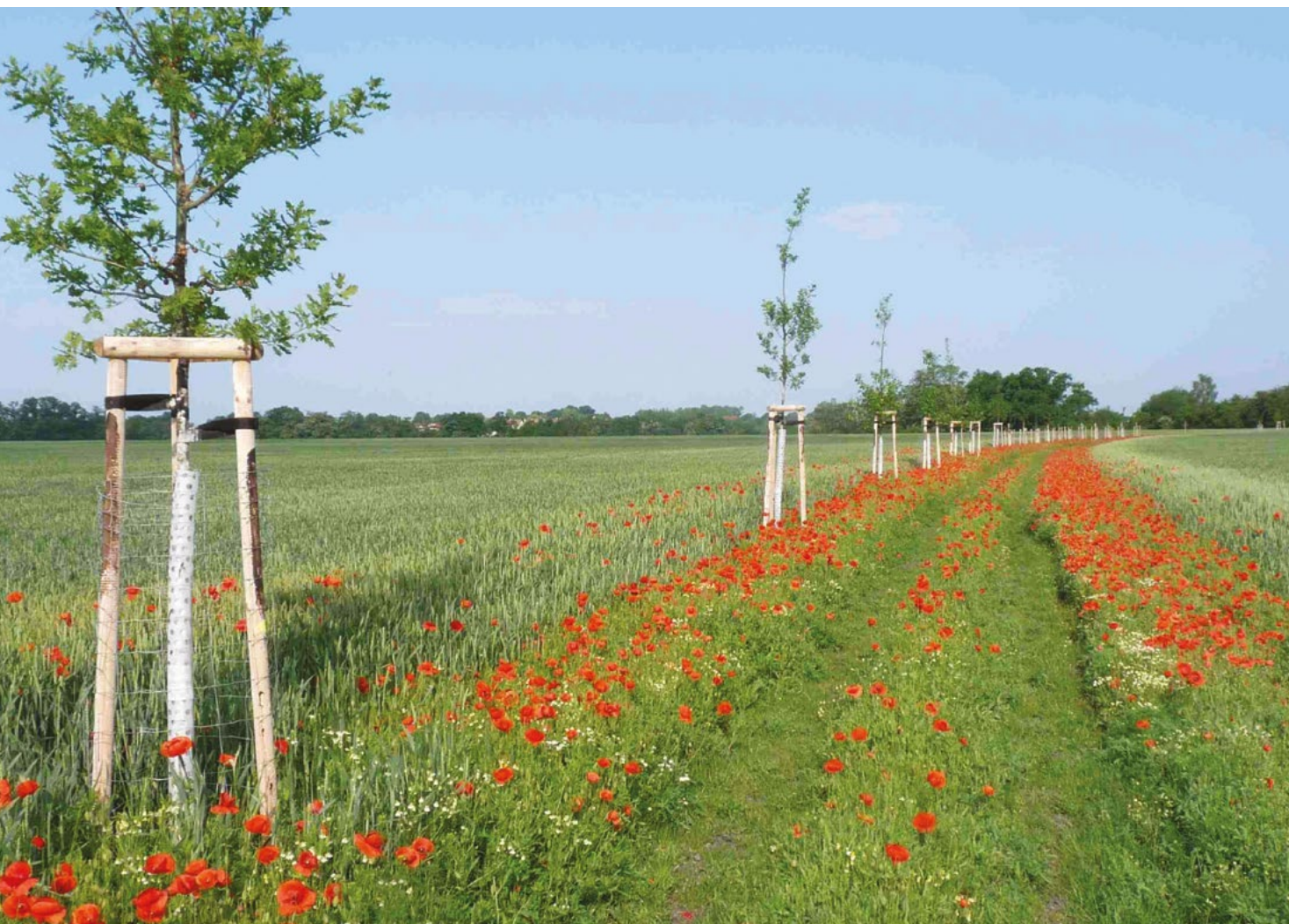
▲ Obnova polní cesty se stromořadím v Chorušicích, cesta je založena technologií šterkového trávniku s únosností pro zemědělskou techniku (Martina Havlová, Martina Forejtová, Ondřej Valigura). Foto Martin Bauer
