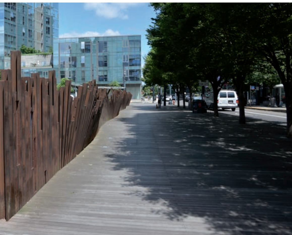
Příklad inteligentně vyřešeného veřejného prostoru. Povrch ulice města Portland (USA) u Tanner Springs Park je řešen dřevěnými chodníky, pod kterými je skryta infrastruktura. Voda je sváděna do dešťových zahrad, kde postupně vsakuje nebo je využívána pro oběh potoků. Stromy nemají založenou korunu v podchodné výšce.. Ulicemi jezdí české tramvaje
