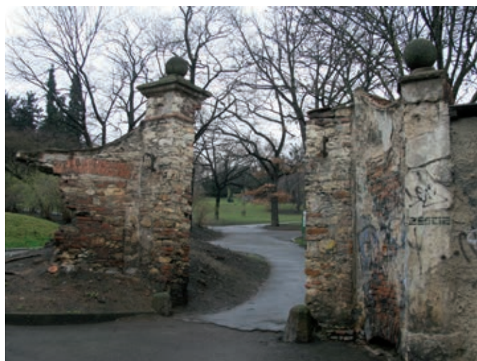
Původní stav brány Vozová
