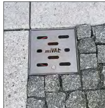
zavlažovací hlavice do chodníku při napojení drenážní hadice k závlaze stromů
