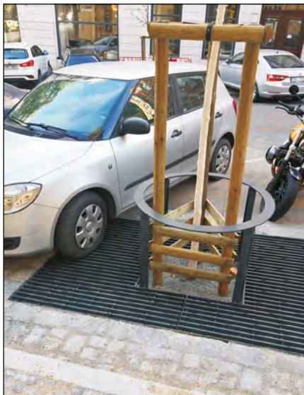
ochrana stromů s pojezdovou ocelovou mříží zvláště vhodná k rozšíření parkovací plochy
