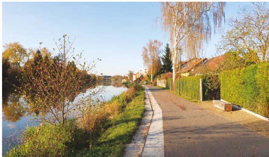
▲▲ Plánské nábřeží: plovoucí molo s žebříkem pro plavce a vazáky pro kotvení lodí
