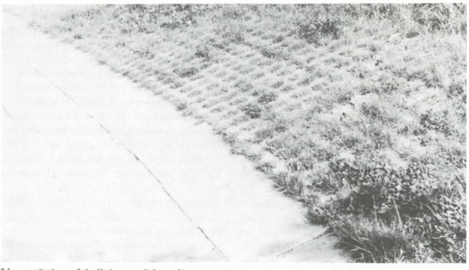
Vegetační prefabrikáty podchycují zatravněný svah nad zpevněným příkopem pro případ, že korytem bude protékat nárazově větší množství přívalové vody.
